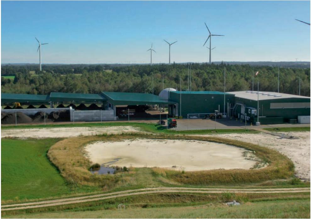
Bau der Trockenfermentationsanlage Dörpen
