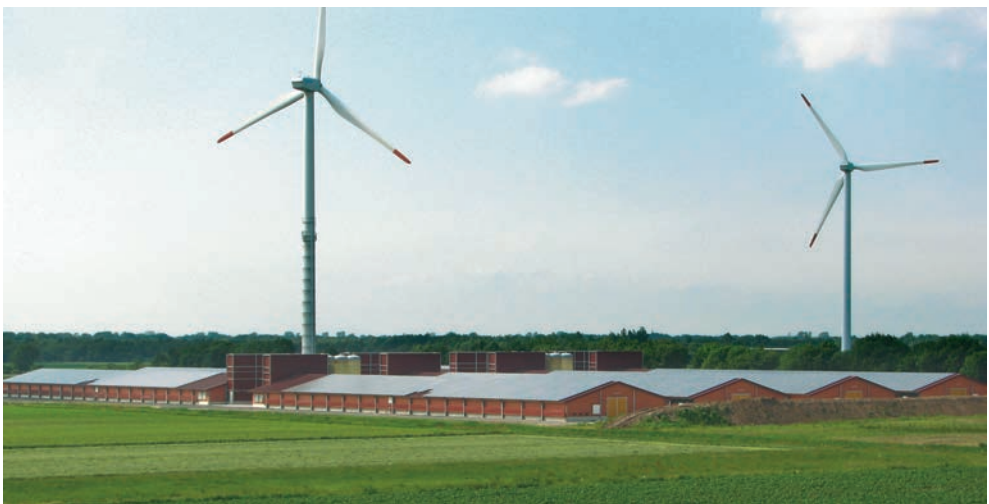
Auf einem Stallgebäude installierte PV-Anlage
